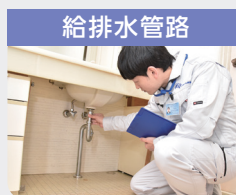
水漏れ、排水不良、滞留等
